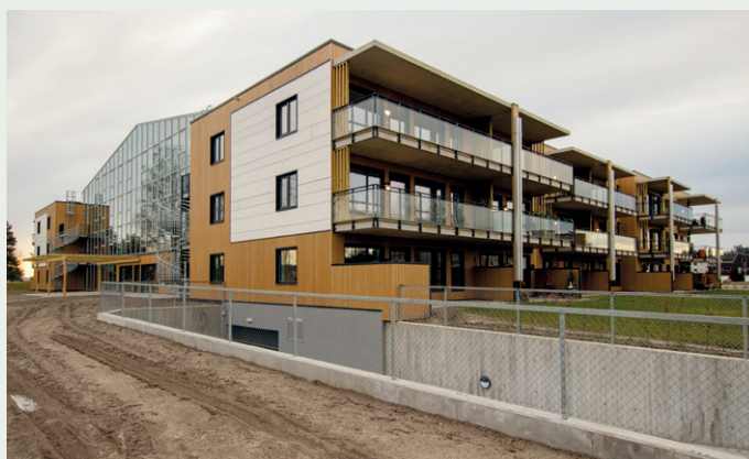
Byggene har en felles garasjekjeller med nedkjøring i enden av hesteskoen.
